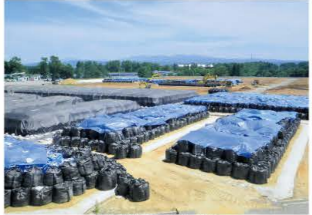
中島村仮置場搬入状況
