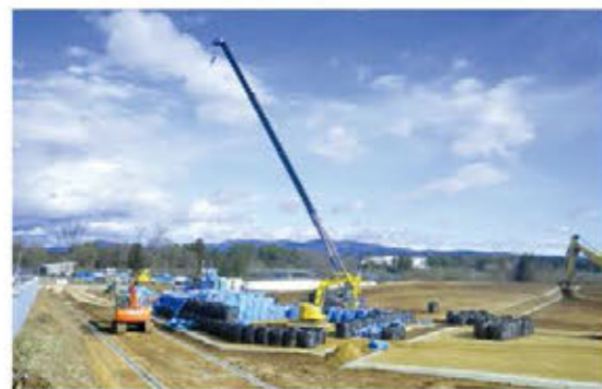
中島村仮置場
