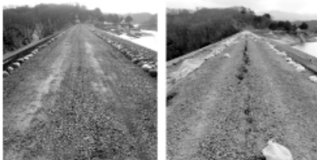
復旧完了状況 (H25.1/ ダム左岸天端部より撮影)
