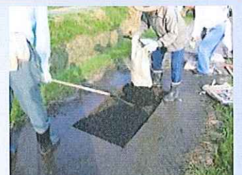
農道の部分補修
