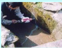
水路のひび割れ補修
