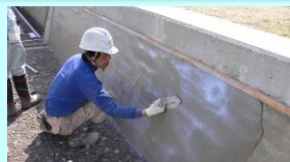
老朽化した水路壁のコーティング
