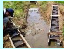
水田魚道の設置
