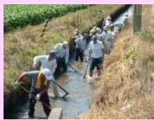
水路の泥上げ
