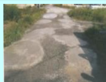
農道の窪みの補修
