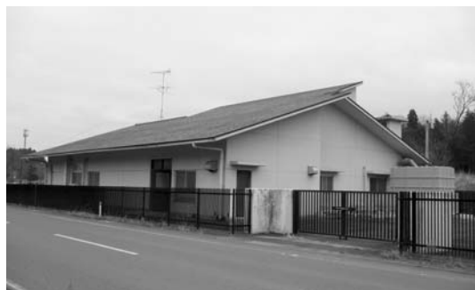
機能強化事業により改修中の滑津原集落排水処理場
