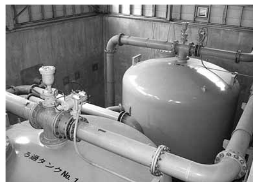
修繕工事予定の急速濾過機
