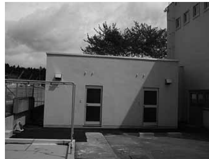
増築された吉子川小北校舎便所
