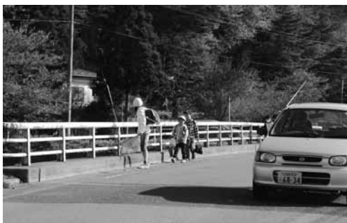
歩道設置が望まれる代畑橋
