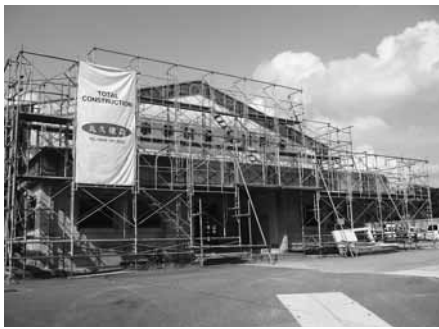
大規模改修中の滑津小
