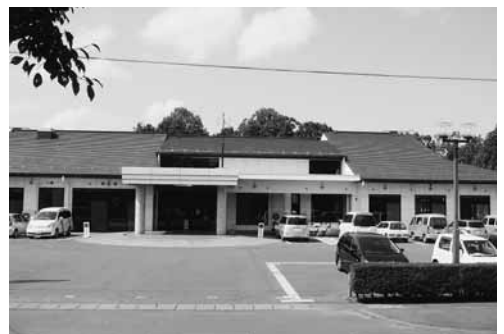
太陽光発電が設置される福祉センター
