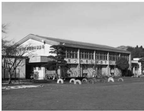
耐震補強・大規模改造工事を行う吉子川小
