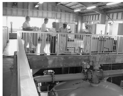
監査委員による現場確認
