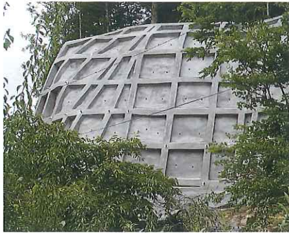
地域防災がけ崩れ対策事業(松崎上井地内)
