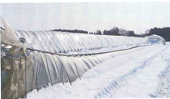
パイプハウス被害状況
