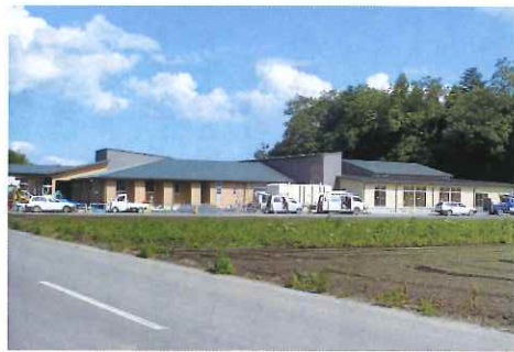
建設が進む特老施設
