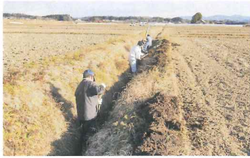
水路の土砂上げ
