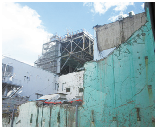
廃炉作業が行われている福島第1原発第3号機
