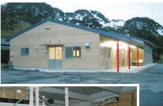
防災センター
