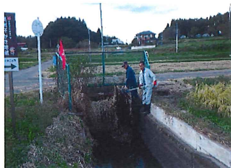
・大型排水路堆積物撤去作業（防災・減災力の強化）
