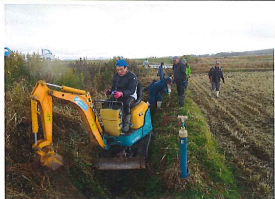
・泥上げ作業
