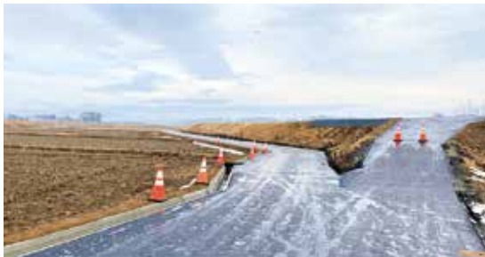
農道改良舗装工事(天神前地区)
