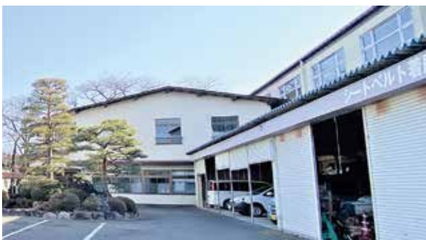
分庁舎（正面奥）と車庫
