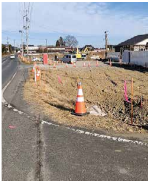
川原田バイパス工事（常陸橋側から）
