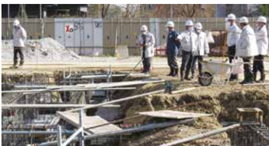
給食センター工事状況視察
