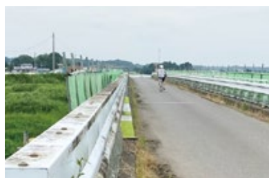
吉岡橋の通行状況
