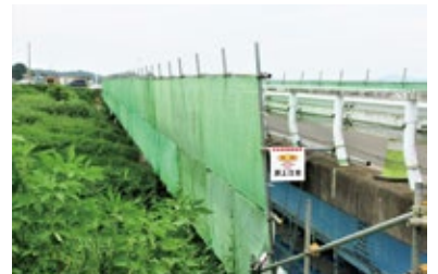
下部補修(クラック等) 工事中の吉岡橋
