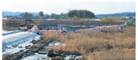
大欠堰災害復旧工事
