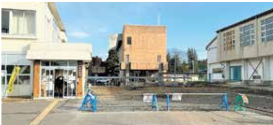
解体が終わった役場分庁舎跡
