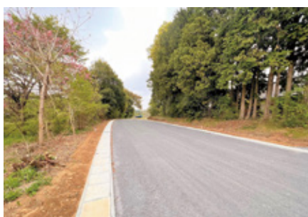
滑津後山線改良工事
