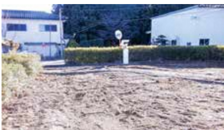
原山地区公園遊具撤去工事
