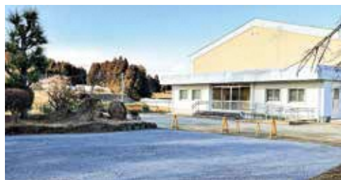
滑津小学校南駐車場造成工事
