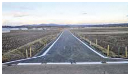
農道長寿命化事業（天下一地区）
