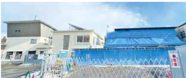
役場庁舎整備事業庁舎建築工事
