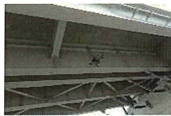
ドローンによる桁下の点検
