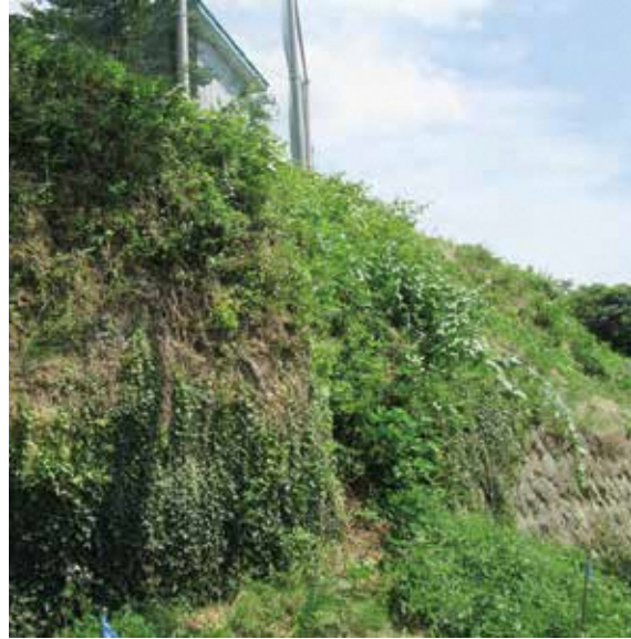
滑津小学校南側法面
