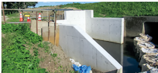
代畑地区排水ポンプ施設設置造成事業
