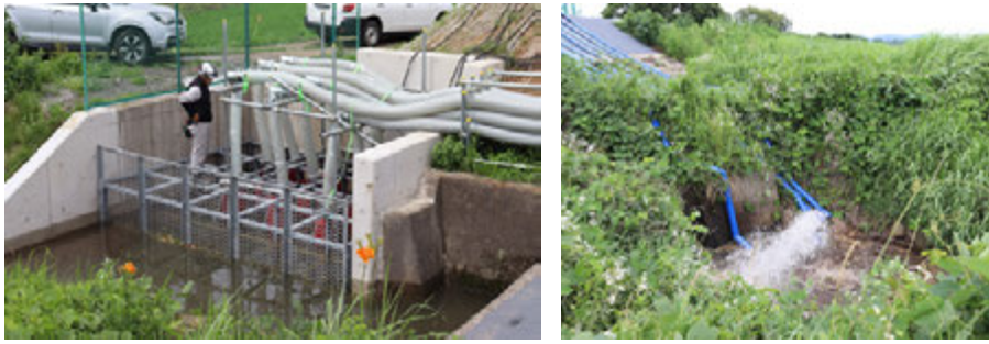
排水ポンプ試運転の様子
