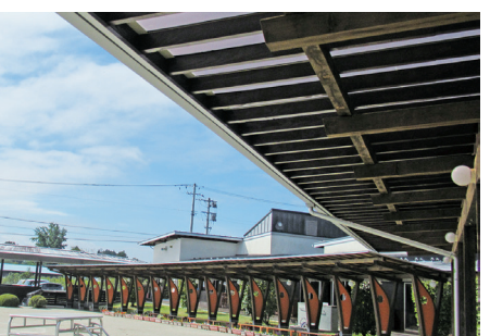
改修した幼稚園の軒下
