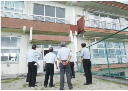
滑津小学校エキスパンション部
