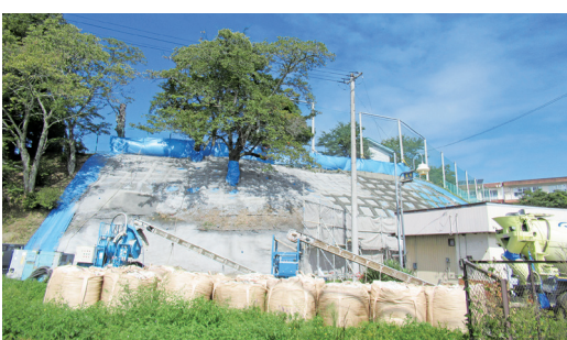
改修中の滑津小学校法面
