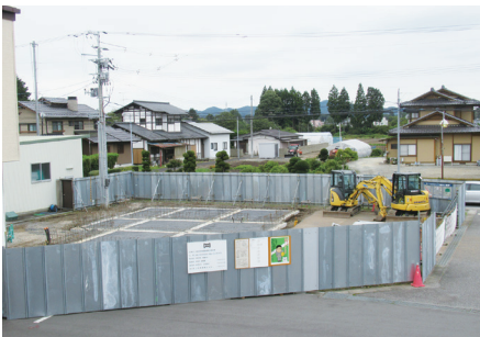
役場整備事業外構工事
